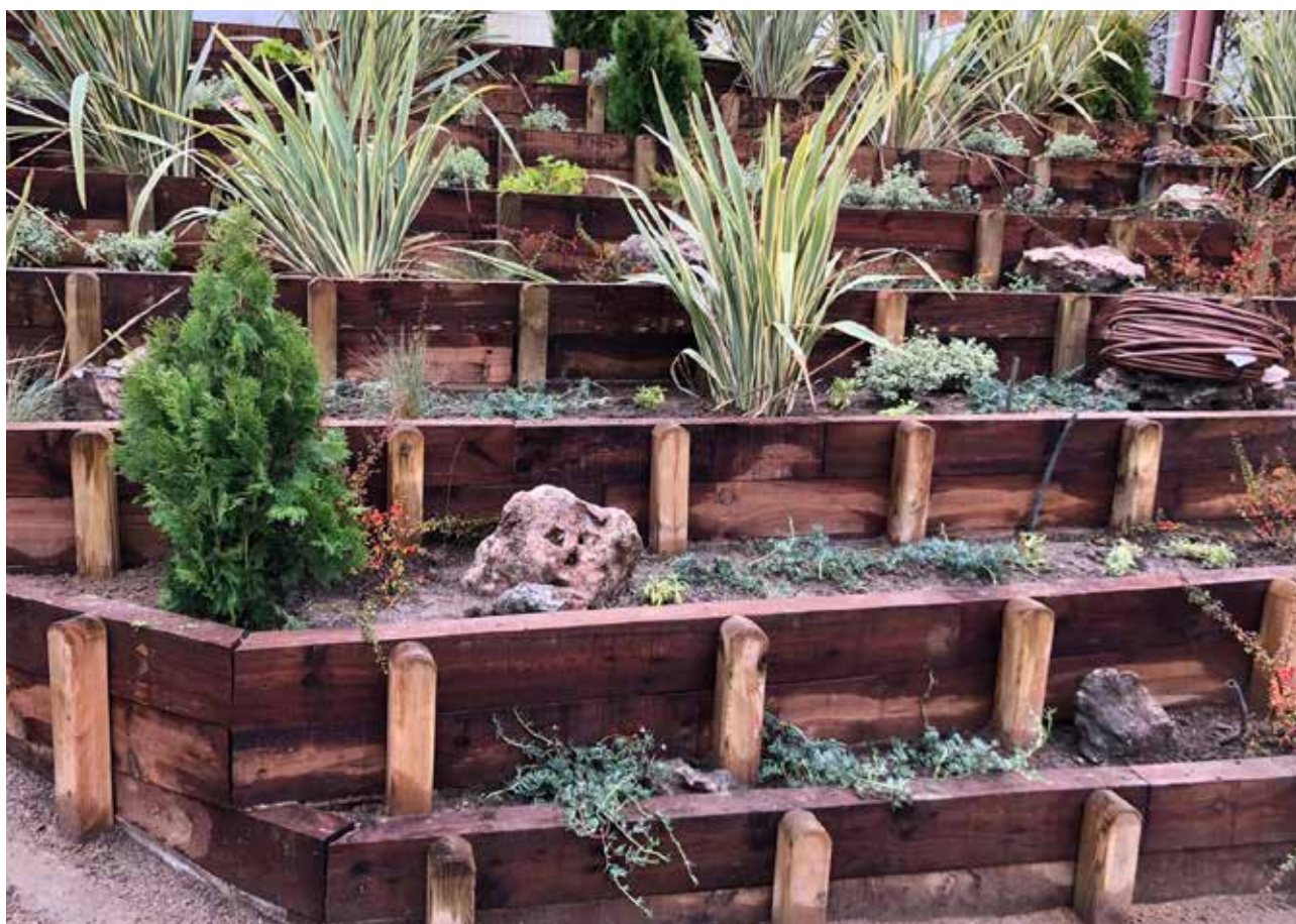
Aplicación traviesa en talud
