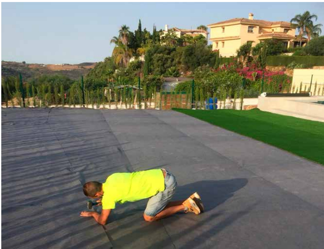
Aplicación de malla antihierbas
